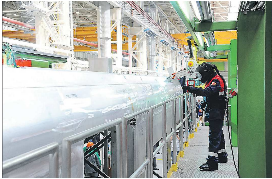
Ответственный момент для работников кузовного цеха завода «Уральские локомотивы» — сварка 25-метрового кузова первого электропоезда нового поколения «Ласточка»
