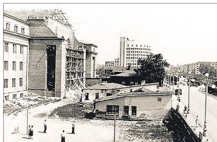
Пятидесятые годы. Строительство университета. Кстати, советская неоклассика отличается массивностью входной группы — поэтому сооружению именно этой части уделялось особое внимание
