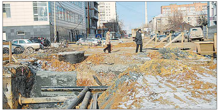
На зиму подрядчик предлагает засыпать дорогу щебнем и временно открыть две полосы для проезда
