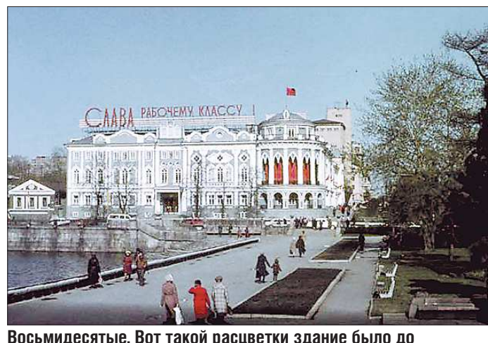
Восьмидесять. Вот такой расцветки здание было до реконструкции. В ротонде вывешены красные знамена — стены там тоже были голубыми
