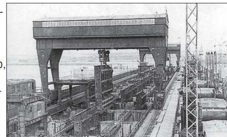
Поднятие затвора водослива козловым краном. Камская ГЭС, 1955 год
