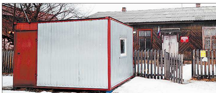
Специально установленный в центре поселка вагончик, оборудованный под опорный пункт полиции, пока что стоит необжитой
