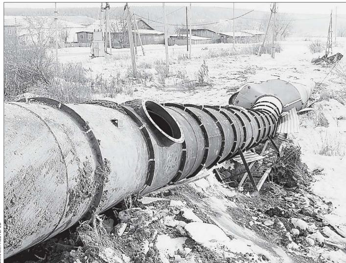
По одной из версий причиной крушения могла стать некачественная сварка стыков металлической конструкции
