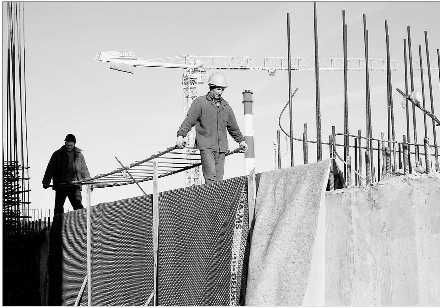
Все амбициозные проекты начинаются с обычной стройплощадки
