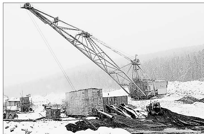
Экскаваторно-гидравлический комплекс – начало золотого потока
