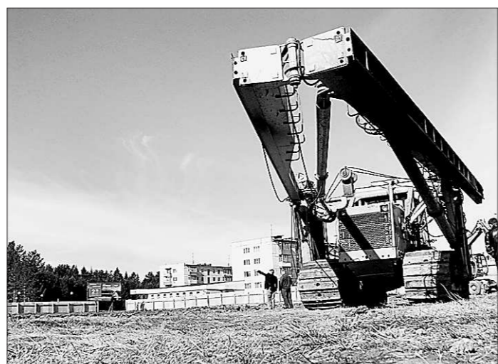
Сейчас строители работают над фундаментом, а к концу ноября планируют приступить к монтажу металлических конструкций
