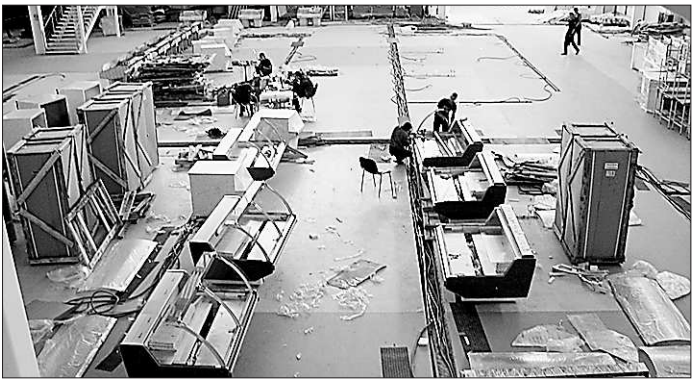
В помещениях выставочного центра сейчас монтируют оборудование
