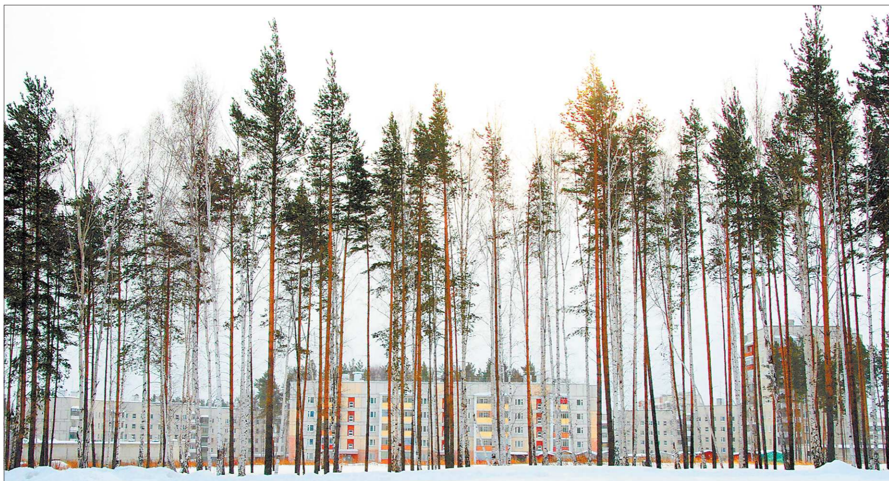
Дома построены, деревья посажены, кадры появляются. (Дома возведены в Полевском компанией ТМК для своих рабочих). Фото Станислава САВИНА
