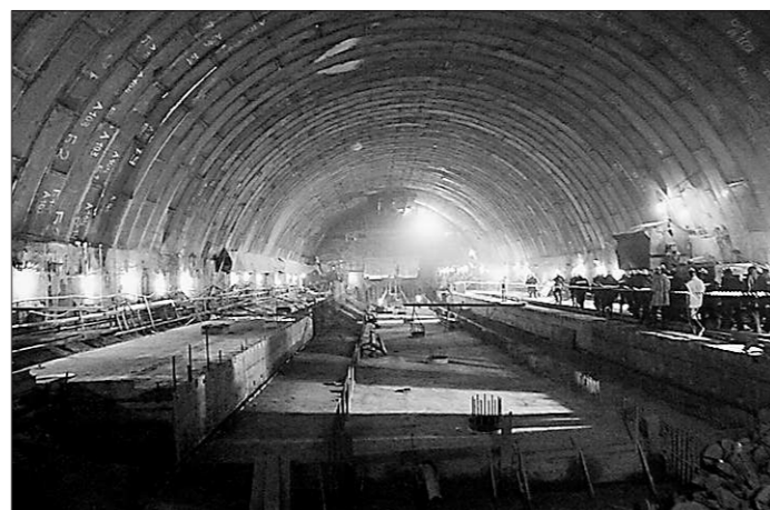
Метростроевцы продолжают проходку. Фото Алексея КУНИЛОВА
