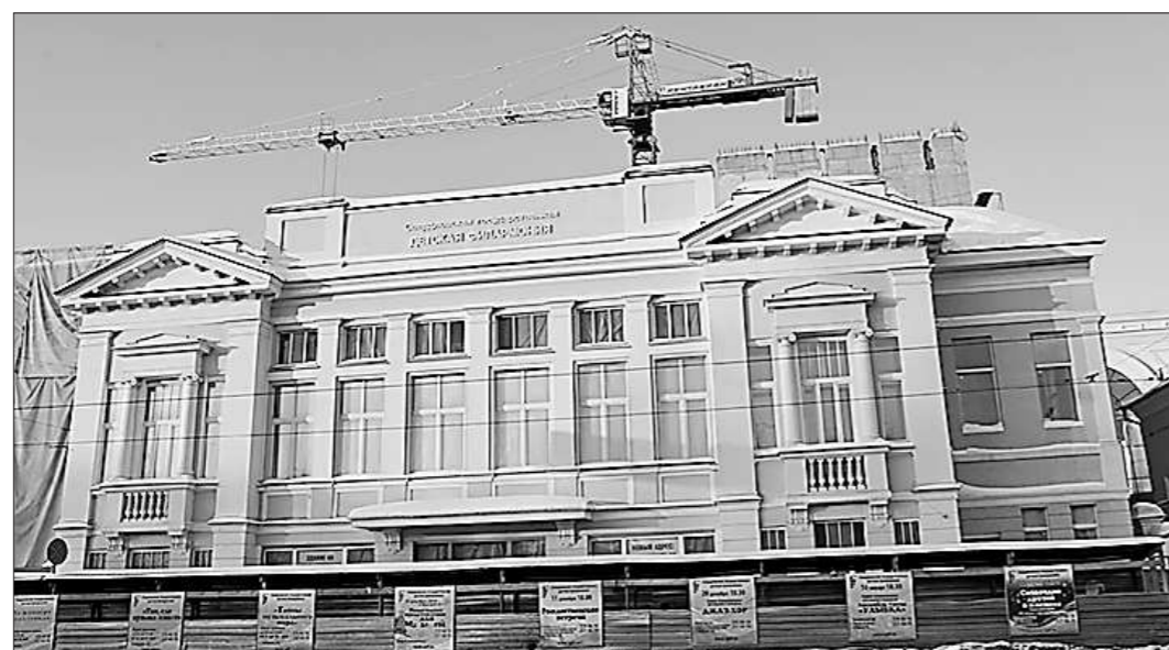
Так выглядит стройка сегодня. Фото Алексея КУНИЛОВА
