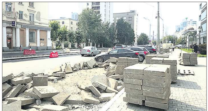
На улице Куйбышева стройматериалы рабочие сложили на тротуаре
