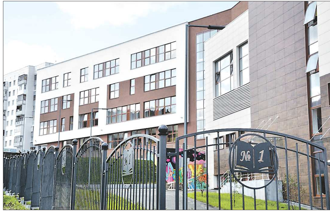
Новую школу №1 на Верх-Исетском бульваре, 23 взамен снесённой старой строили два года
