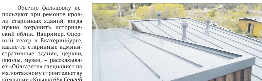
Фальцевая кровля широко используется и при строительстве частных домов, и при реставрации старых зданий
