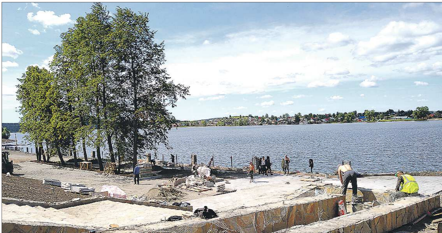
На одном из участков набережной подрядчики уже укладывают тротуарную плитку
