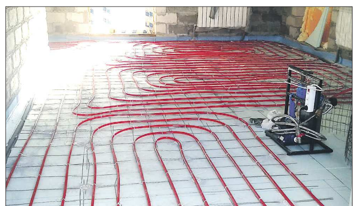
Так укладываются трубы водяного отопления для тёплого пола
