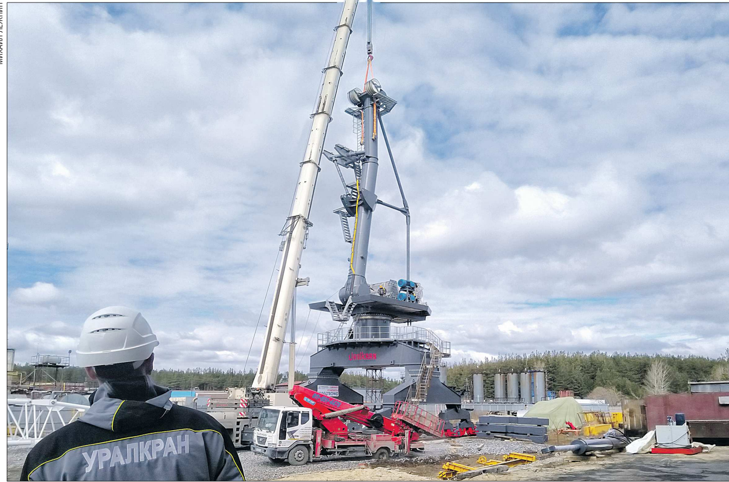
Грузоподъёмность крана - 85 тонн, высота подъёма - более 70 метров. Кран предназначен для работы в речных и морских портах, на судостроительных заводах или может быть установлен на рельсовую, колёсную или корабельную платформу для работы в открытом море
