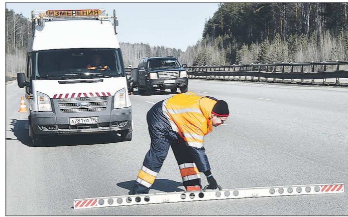
Отремонтированные в 2017-2018 годах участки Серовского тракта и сейчас в идеальном состоянии
