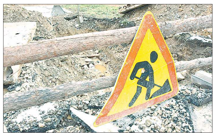
В текущем отопительном сезоне в области произошло 182 коммунальные аварии
