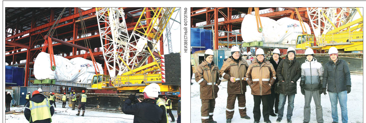
Турбина весит 340 тонн. Специалисты «Атомстройтехники» и «Уралэнергомонтаж» смонтировали тяжёлое оборудование в рекордно короткие сроки — всего за несколько часов
