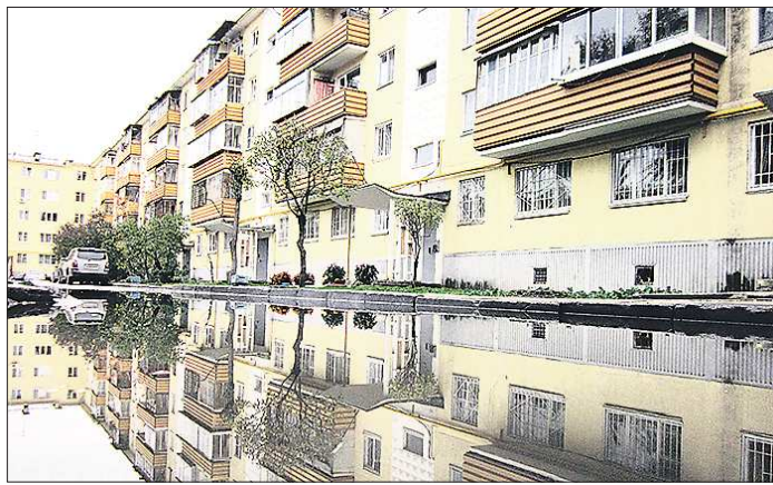
Это бескрайняя лужа во дворе дома № 9 по улице Онежской в Екатеринбурге. Каждую осень она доставляет жителям массу неудобств. Ликвидировать подобные ЧП локального характера гораздо легче, когда у района есть свой бюджет
