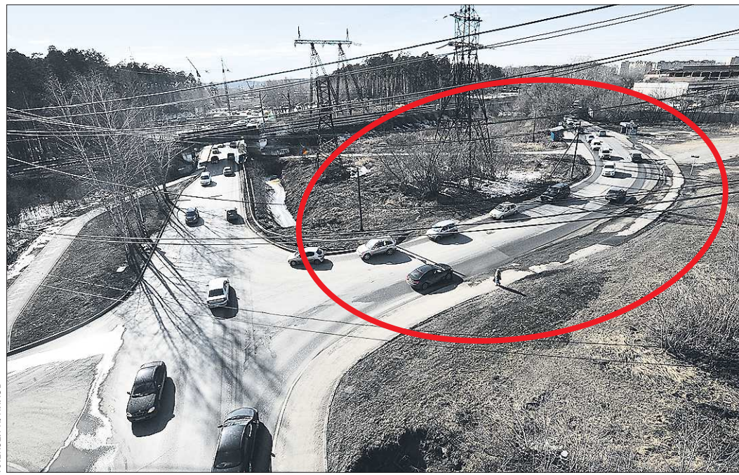
Из микрорайона Компрессорный не выбраться — есть только один выезд в город, который утром и вечером заполнен автомобилями. Второй выезд обещают построить... уже не первый десяток лет. Игорь Иваненко уверен, что подобные проблемы будут решаться быстрее и эффективнее, если в районах будут свои Думы и свой бюджет
