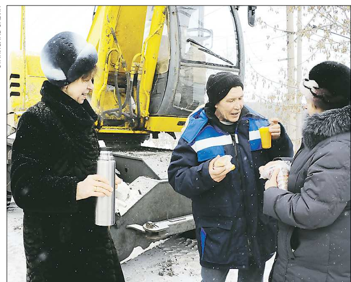
Жители Сухого Лога привозят еду и горячие напитки бригадам ремонтников, которые практически в круглосуточном режиме занимаются восстановлением водовода
