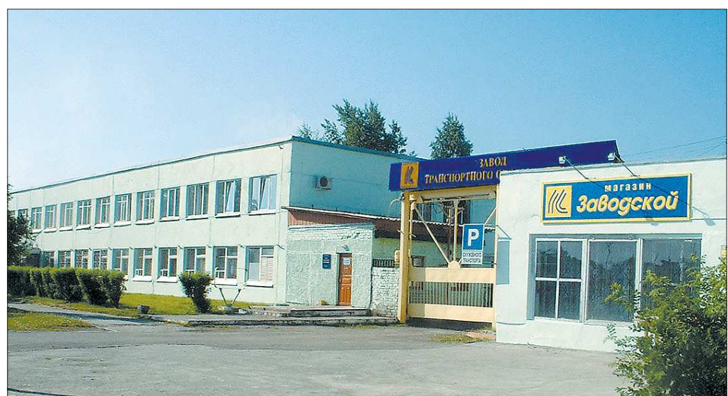
У заводской проходной
