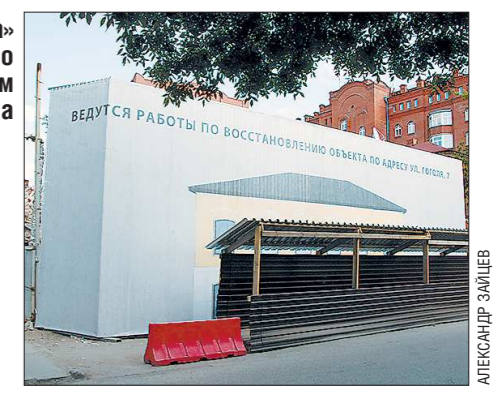
«Областная газета» обязательно проследит за ходом строительства
