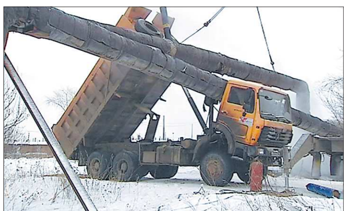
Из-за столкновения грузовика с теплопроводом без тепла остались десятки домов
