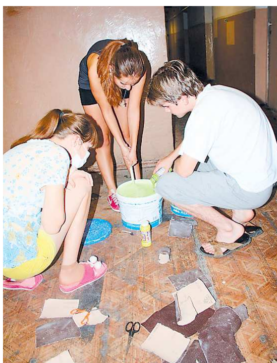
Жители второго этажа решили последовать примеру пятого и тоже взялись за ремонт.
