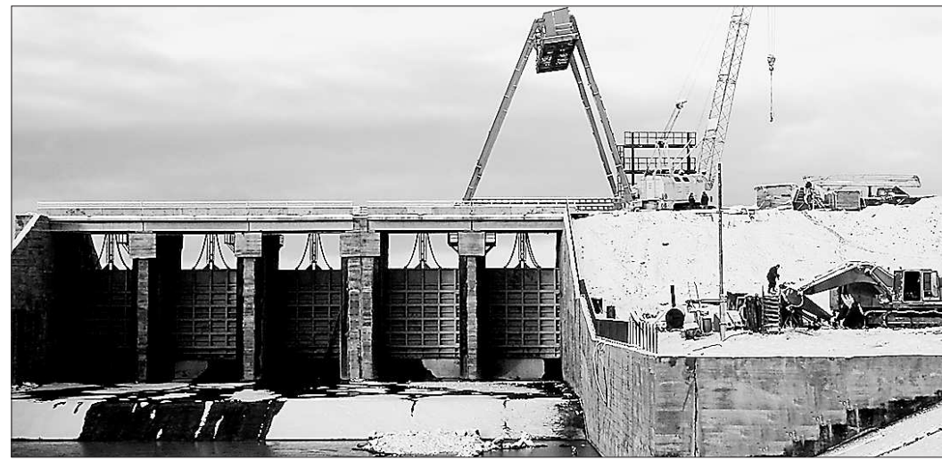
Ещё одно новое гидротехническое сооружение — Алапавская плотина, на строительство которой выделено около 600 миллионов рублей, растёт на глазах. Фото Анатолия ГУЩИНА
