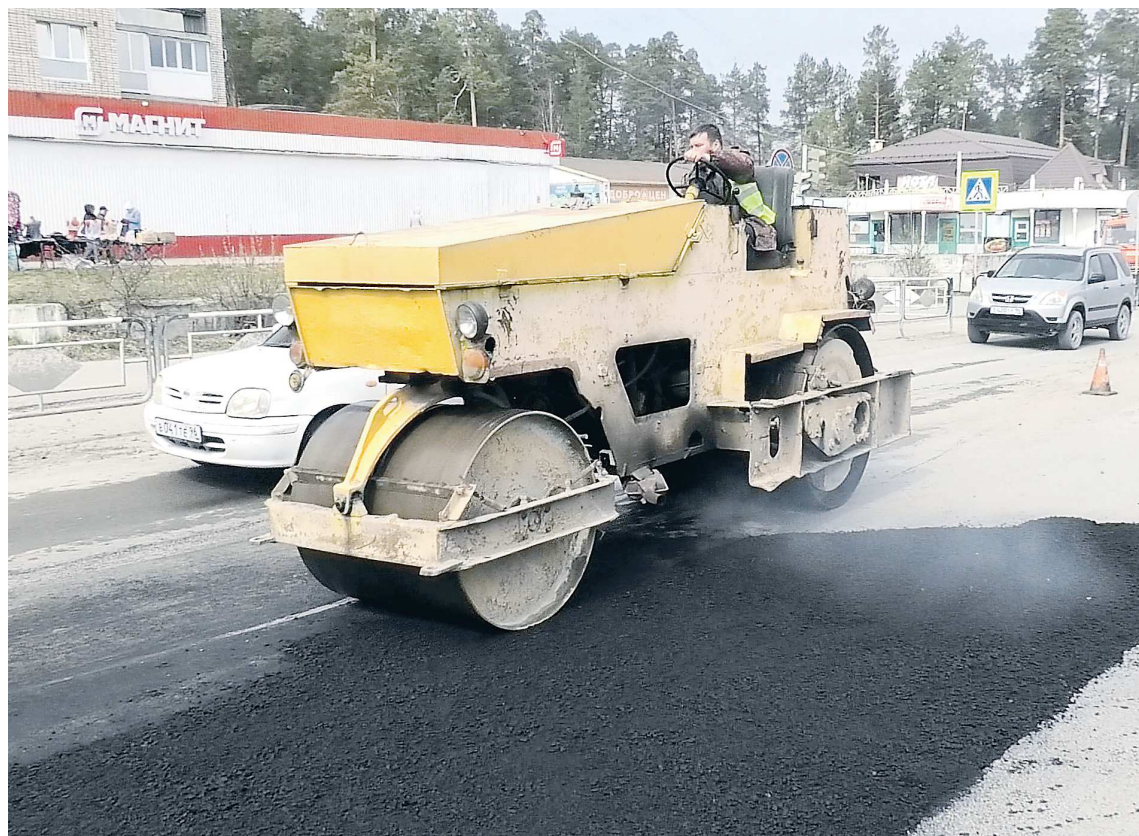
В этом году объем работ только по ямочному ремонту составит около 2,5 тыс. кв. м
