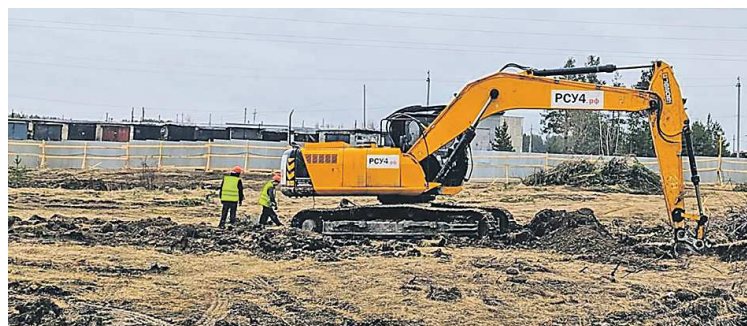
На площадке строительства поликлиники в Режевском ГО готовятся к укладке фундамента
