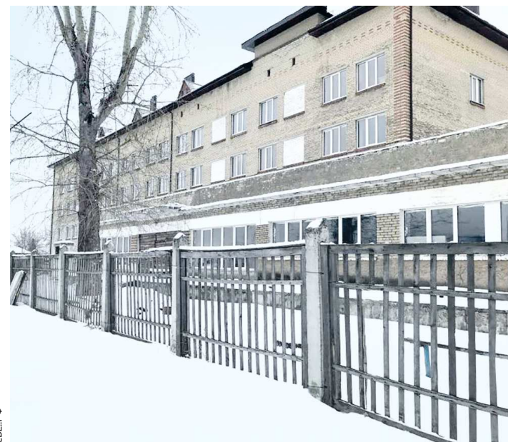
Поликлинику в поселке Буланаш ремонтируют второй год
