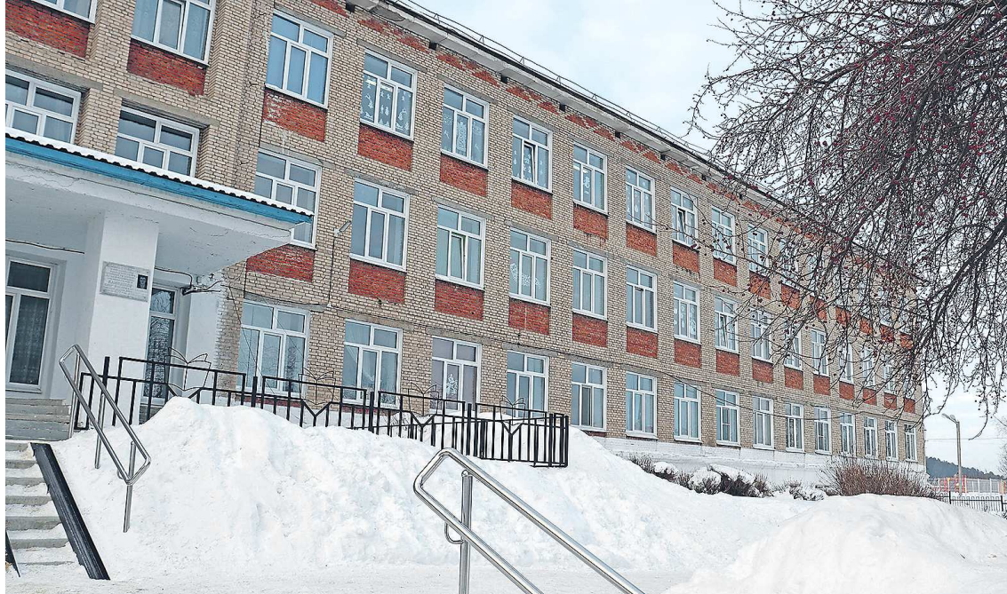
Школа №2 уже готовится к предстоящему ремонту, который начнется в конце февраля
