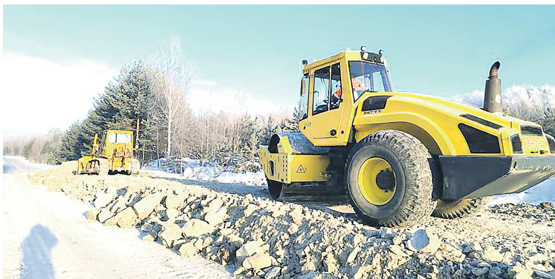
На объект в Сосьвинском городском округе уже вышла дорожная техника
