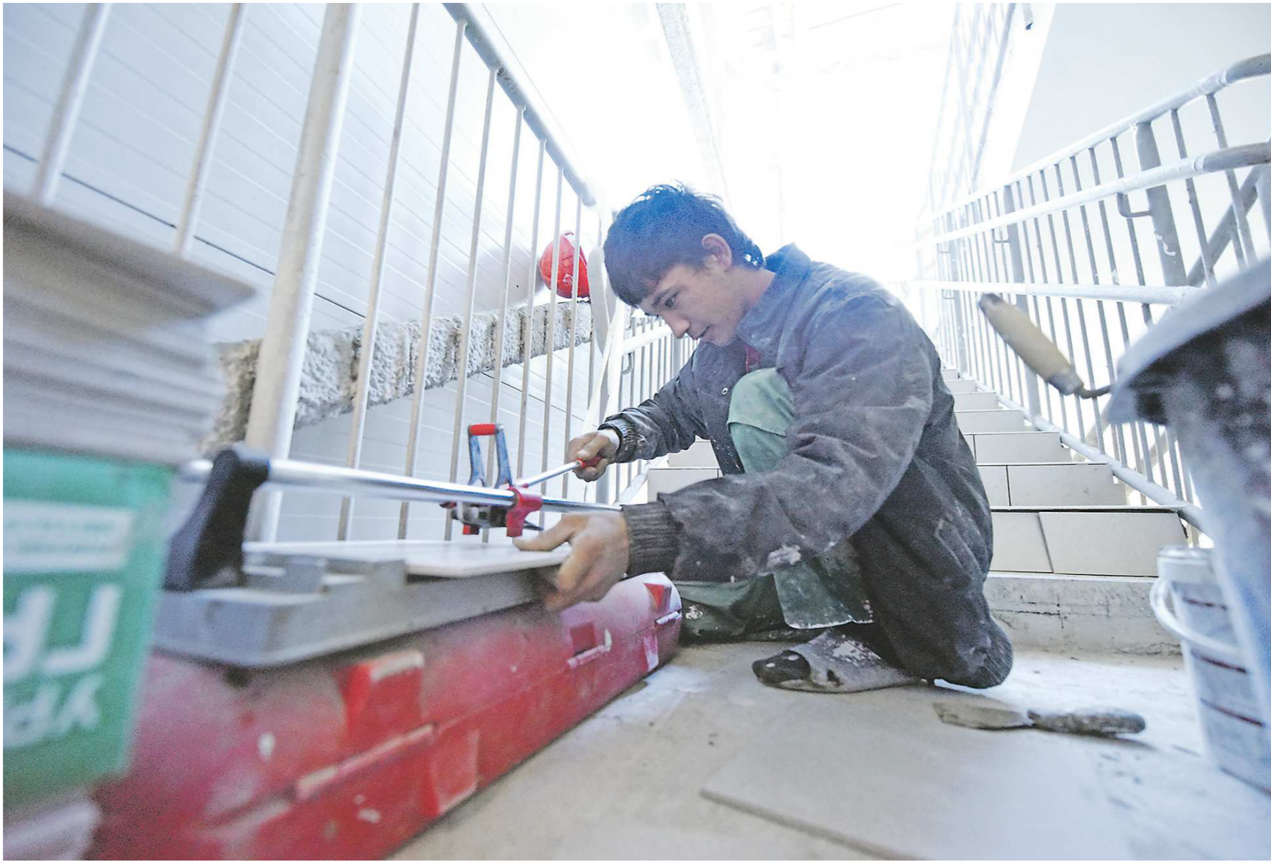
Фронт работ в свердловских поликлиниках большой: от внутренней отделки помещений и замены сетей до установки новой мебели и оборудования
