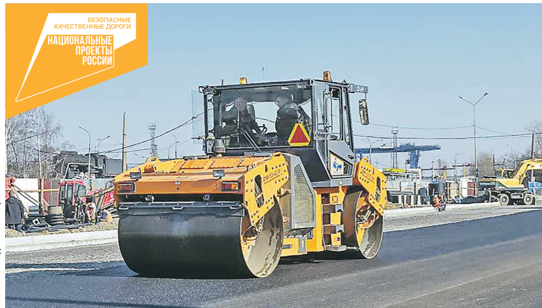
С 2019 года в Нижнем Тагиле благодаря нацпроекту «Безопасные качественные дороги» отремонтировано почти 90 километров автодорог
