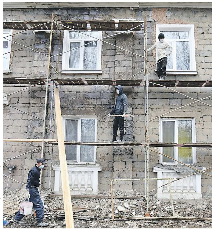
В перечень ремонтных работ входит восстановление фасада дома, замена кровли, внутренних коммуникаций, лифтов
