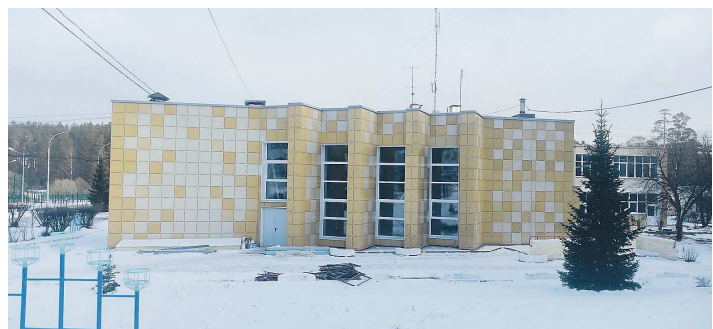
Так выглядит столовая-клуб, где ремонтируют актовый зал
