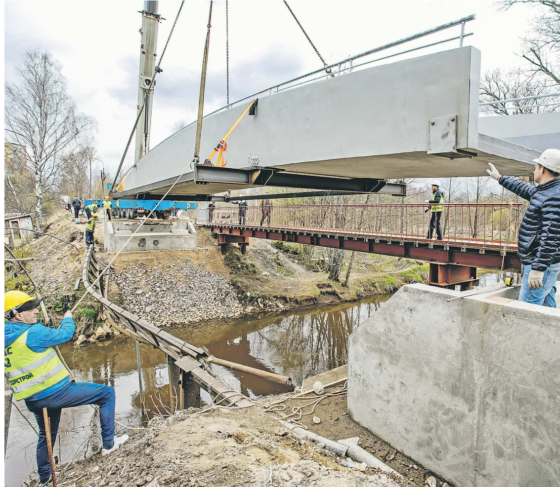
Мост из композитных материалов, впервые построенный в Санкт-Петербурге в 2020 году. Скоро такие появятся и в Свердловской области
