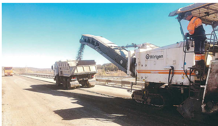
Ремонт автодороги Нижняя Тура – Качканар
