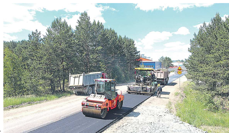
Завершается ремонт автодороги Арамиль – Фомино
