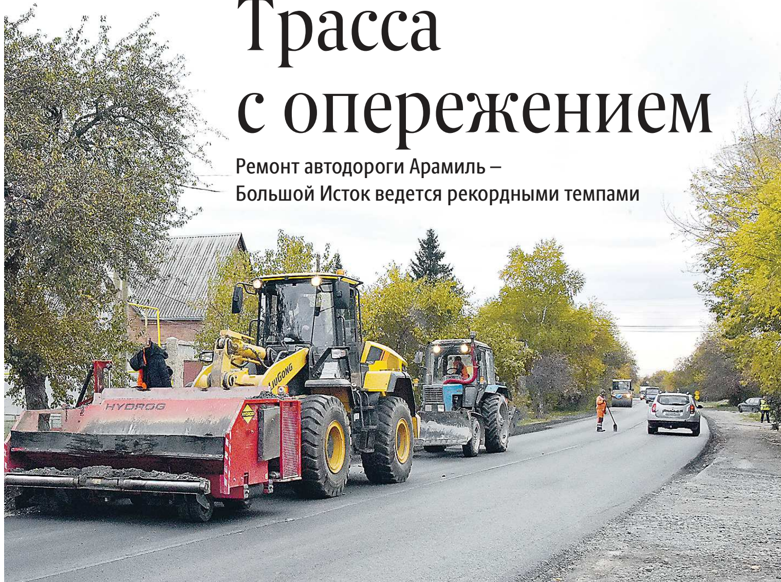
На отремонтированном участке автодороги Арамиль – Большой Исток ведется обустройство обочин
