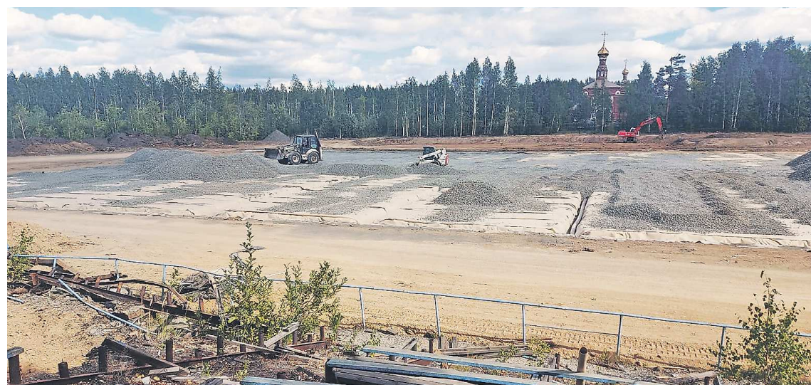
Строительная техника работает на месте будущего стадиона в ежедневном режиме
