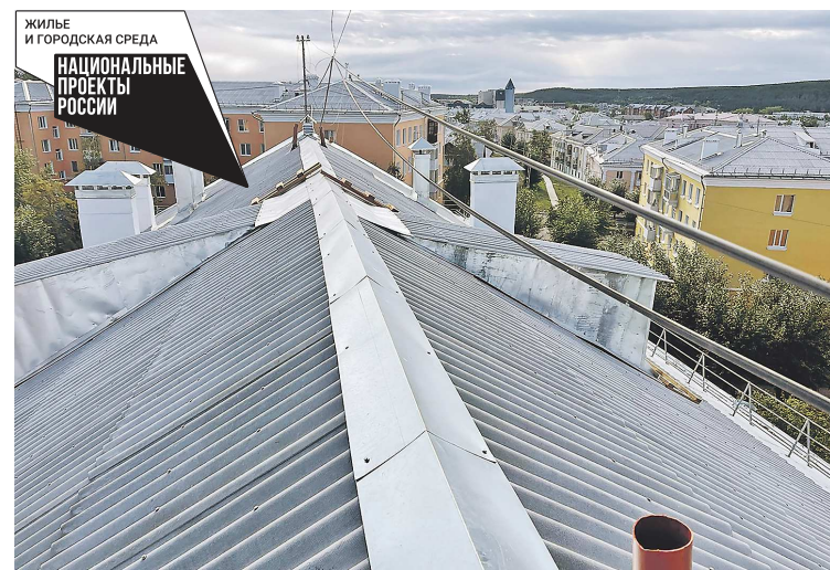
При капремонте самым частым объектом реконструкции в этом году были крыши
