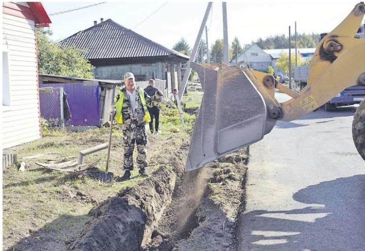
Рядом с новой проезжей частью строители делают стоки для пропуска воды
