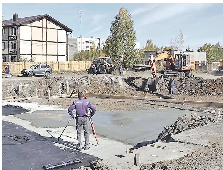
Начало строительства 55-квартирного дома по улице Маршала Жукова, 17
