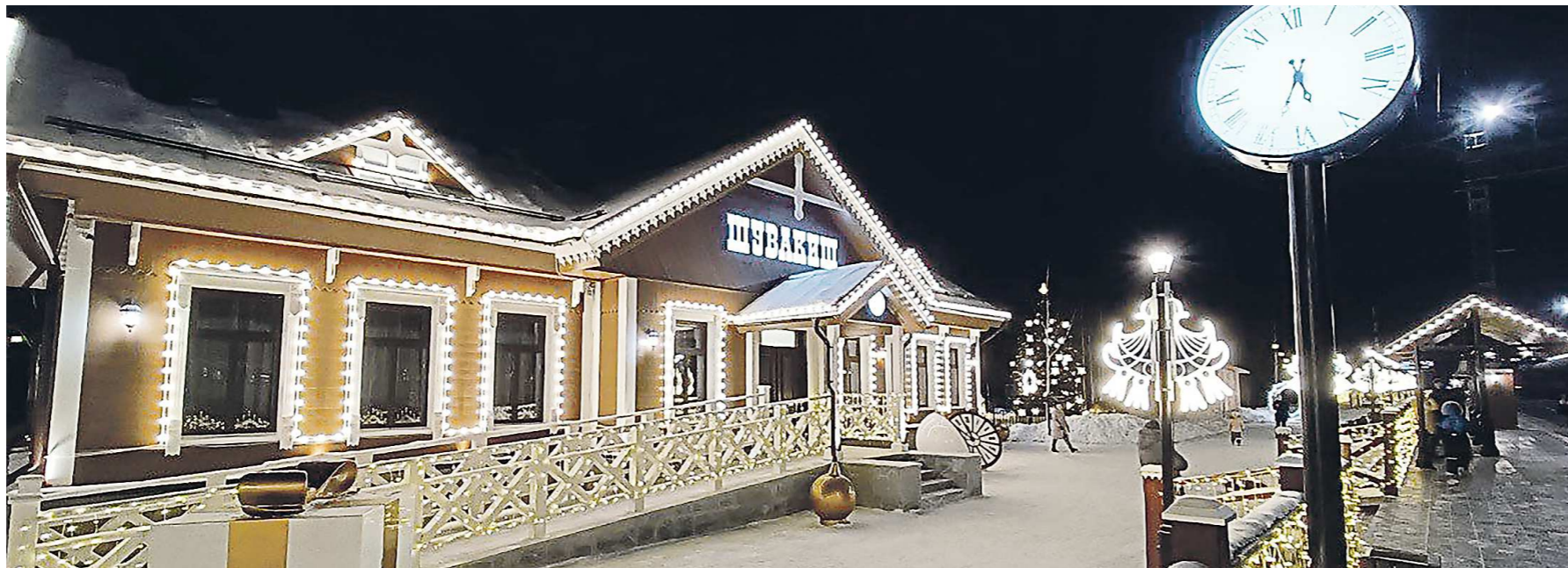
В номинации «Лучшее новогоднее оформление транспортного предприятия» победил вокзальный комплекс на станции Шувакиш – новая визитная карточка Екатеринбурга
