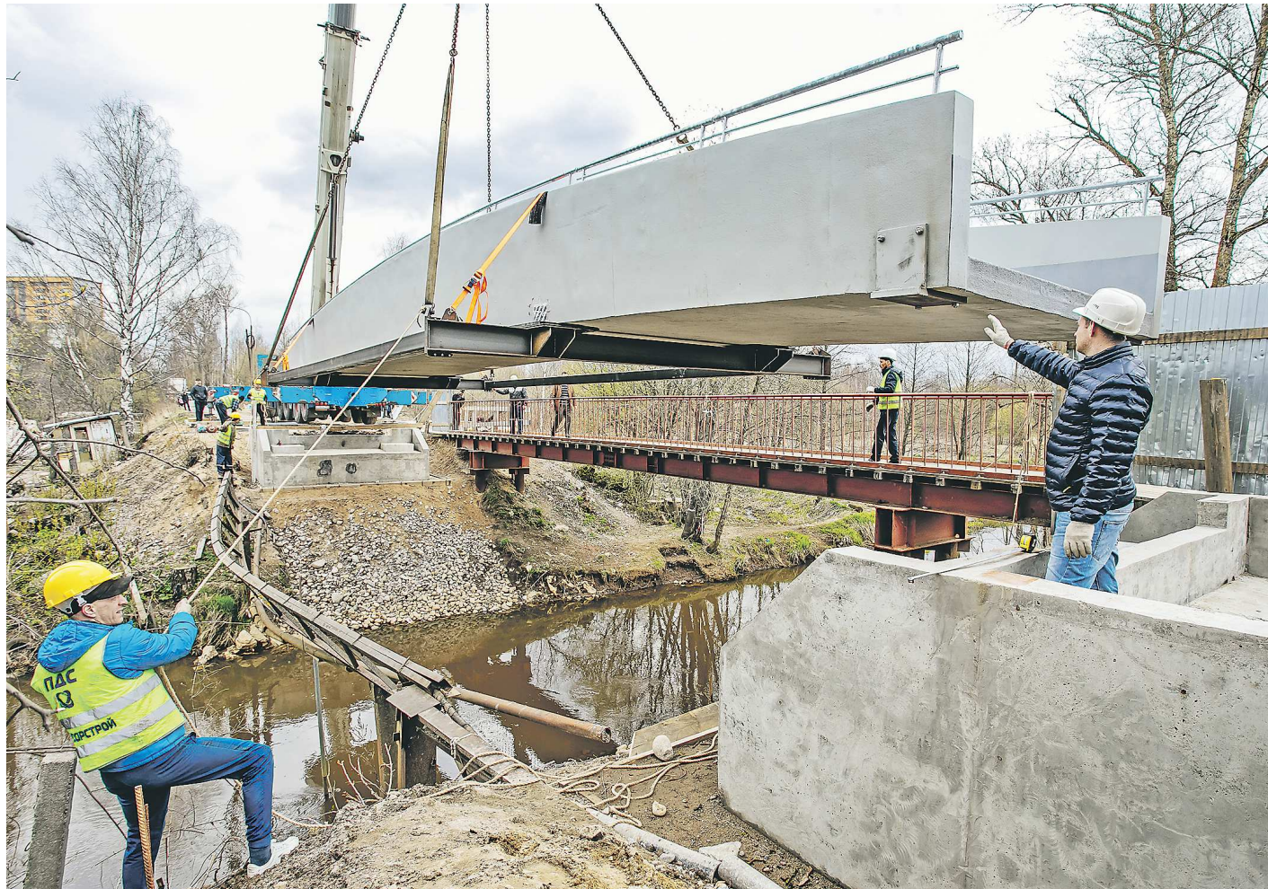
Мост из композитных материалов, впервые построенный в Санкт-Петербурге в 2020 году. Скоро такие появятся и в Свердловской области
