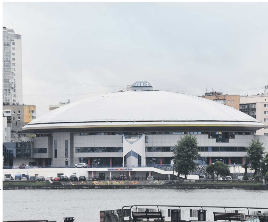
Полная реконструкция Дворца игровых видов спорта завершится в апреле, хотя объект уже принимает соревнования
