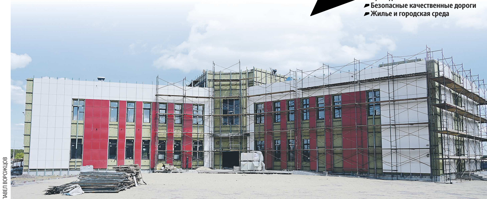
Центр культурного развития в Каменске-Уральском практически построен, сейчас подрядчики занимаются отделкой фасада
